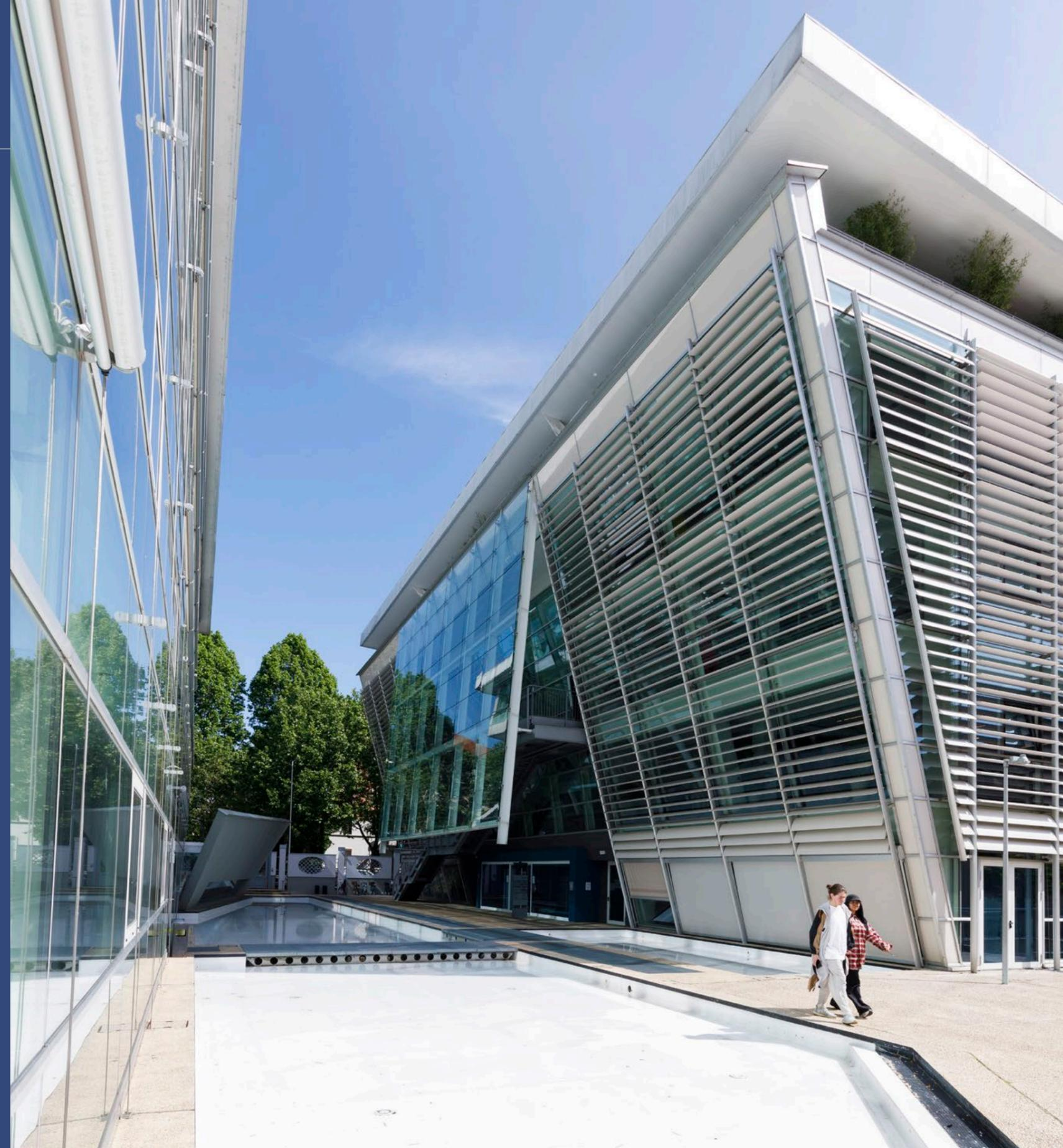
“ Il sistema di ombreggiamento esistente a lamelle frangisole, oltre ad una situazione di sporcizia diffusa, presentava numerose criticità principalmente dovute ad alcuni motori malfunzionanti, all'interfaccia BMS non più operativa e al disallineamento degli apparati previsti per la movimentazione.
